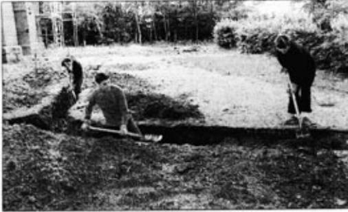
Bis zu 1,20 Meter tief muss der Graben zur Ableitung des Regenwassers in Richtung Schlossgraben werden – eine Knochenarbeit.
