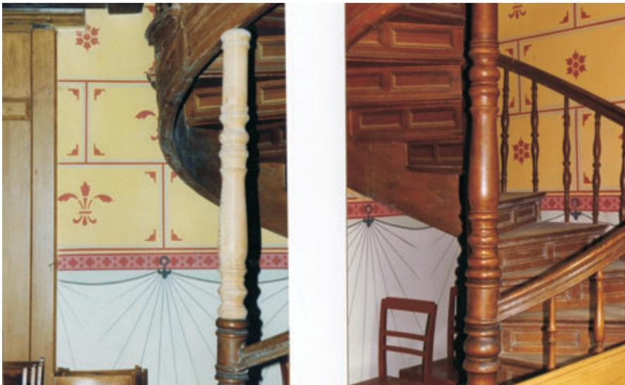
Die Säule ist auf einem Eichenholzsockel mit Nadelholz ergänzt worden. Anschließend wurde sie mit Eichenholzimitation eingefärbt.
