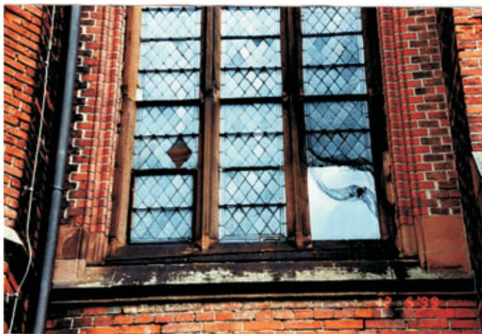
schadhaftes Fenster und verwittertes Mauerwerk, Südseite
